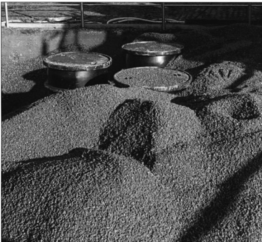
Bild 4: Teilweise eingeschütteter Behälter
