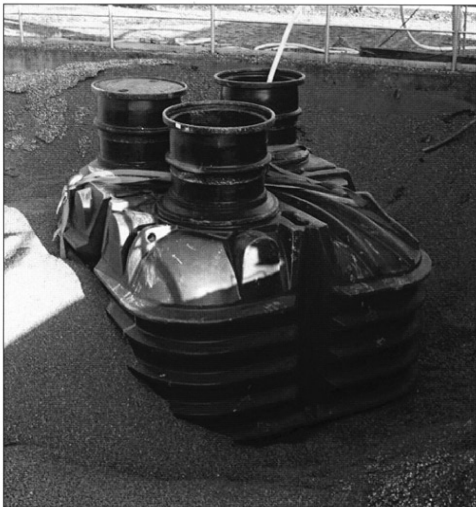
Bild 3: Behälter in Prüfgrube bei Einbau
